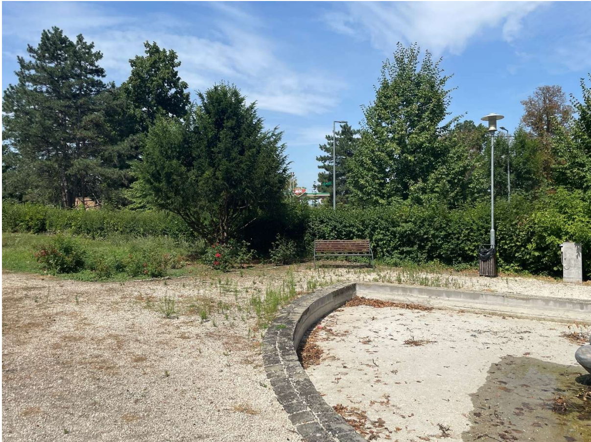
Gyom és üzemen kívüli szökőkút
